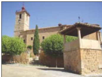
Vista de la iglesia y la torreta
