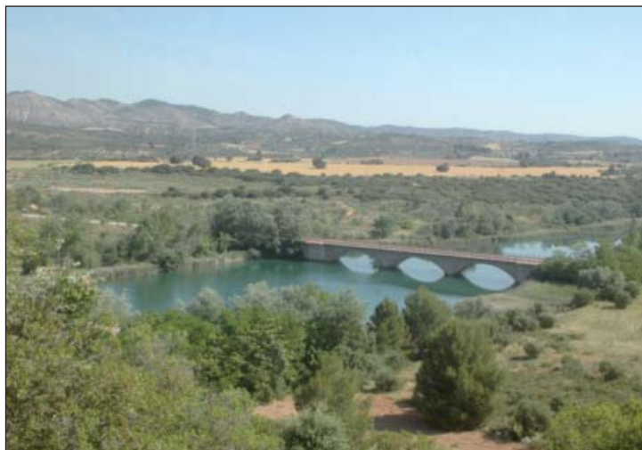
Puente sobre el río Tajo
