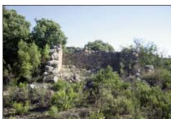
Ruinas de la ermita de San Juan
