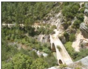
Vista del Puente de Peñalén
