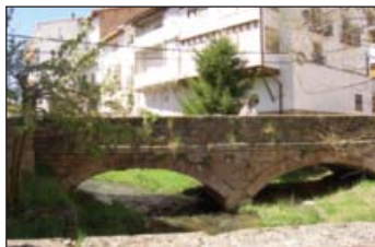
Puente en Checa
