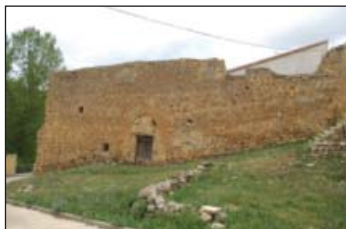
Casa Fuerte del Marqués de Santa Coloma
