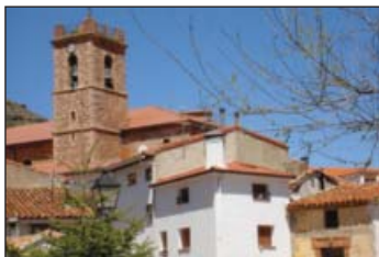
Vista de Checa
