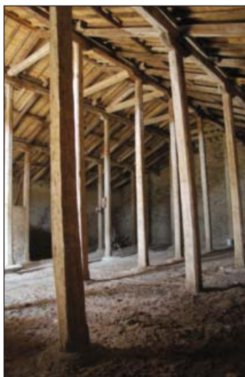
Estructura de madera del almacén de sal
