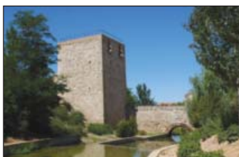
Torreón del Alamin
