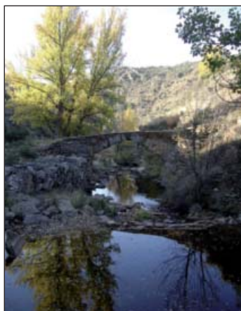
Puente sobre el Arroyo de la Vega
