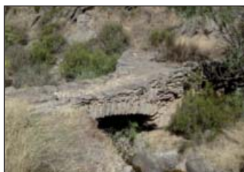
Puente sobre el río Cristóbal
