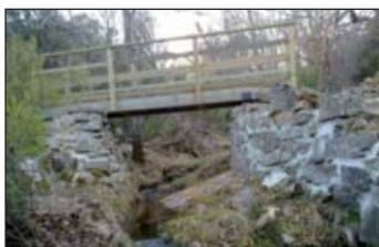
Puente sobre el barranco del Chaparral
