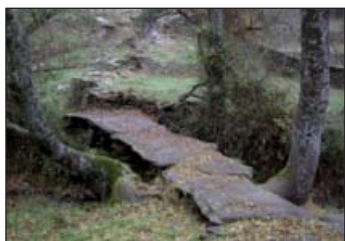
Puente sobre el arroyo de la Casa
