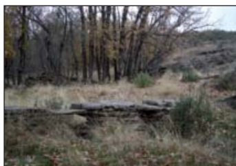
Puente sobre el arroyo Palancosa
