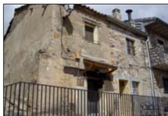
Típica construcción en Arroyo de Fraguas
