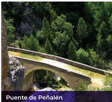
Puente de Peñalén
